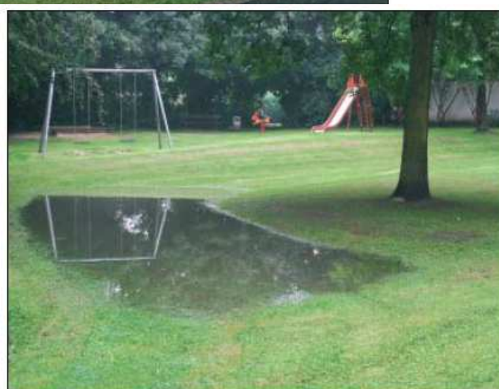
Obr. použit z článku „Odvodňování urbanizovaných území podle principů udržitelného rozvoje“ (Jiří Vítek, časopis Urbanismus a územní rozvoj, 2008)
