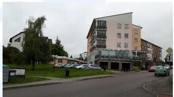
Foto 4: sociální služby, vlevo budovy domova s pečovatelskou službou, vpravo domov pro seniory
